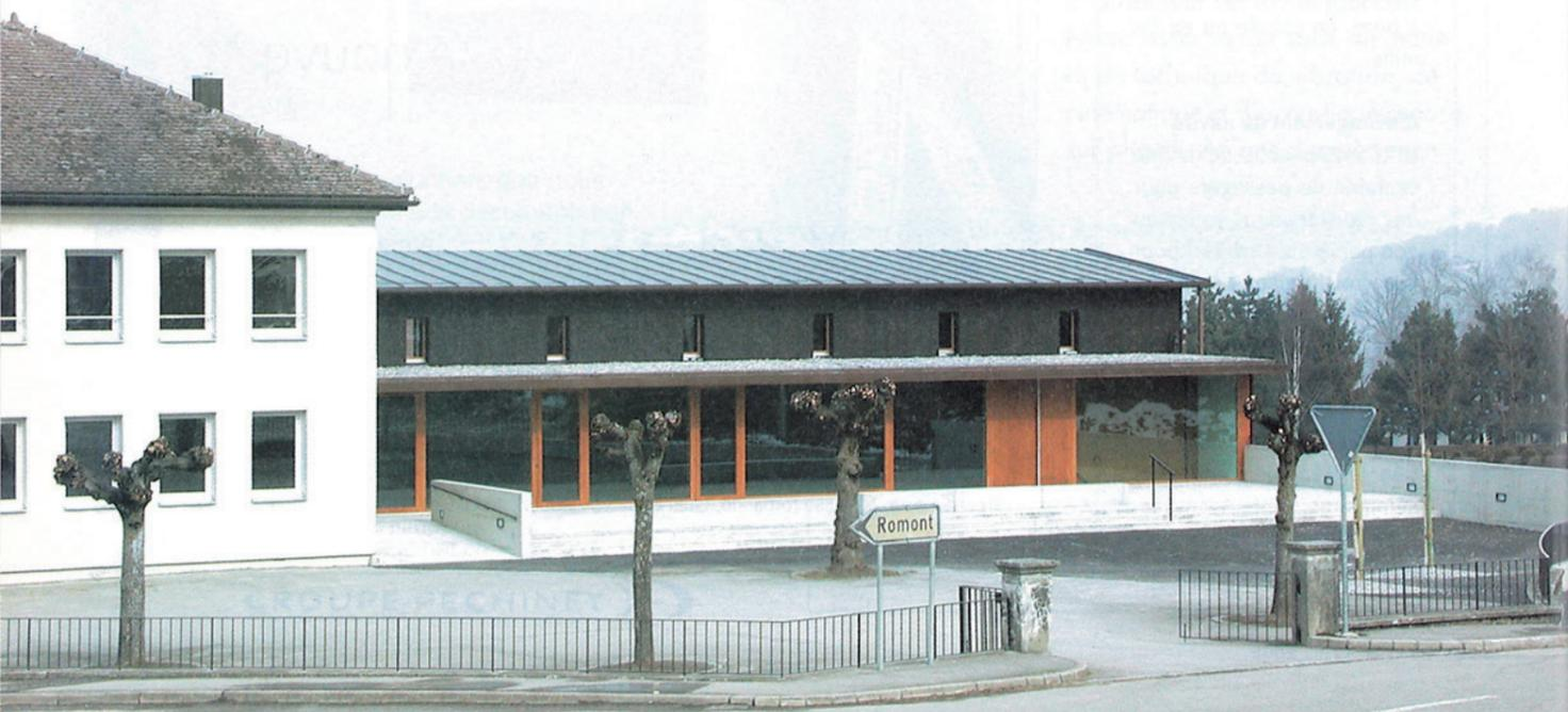
L'expression architecturale recherchée par le maître de l'ouvrage et par les architectes s'inscrit dans une interprétation des éléments constructifs et architecturaux des fermes du village. La volonté de différencier par le choix des matériaux la partie du soubassement de la partie supérieure permet une lecture claire du volume de la salle. Ce volume, en bois, repose sur un socle en béton relié aux murs de soutènement existants.
